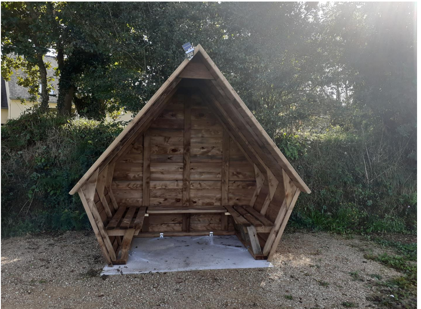
Nouvel abri de bus installé par la Mairie, au lieu-dit Kersaliou au niveau du hameau du verger. Celui-ci a été financé par la commune et Groupama.
